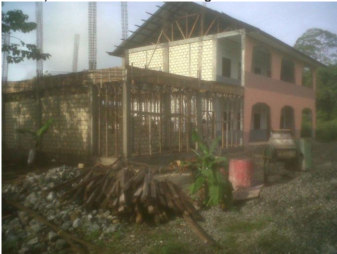
Het Antonius college verder in aanbouw .... Stand Januari 2014
