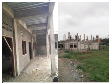
De aanbouw van het jongensinternaat van het Antonius College
